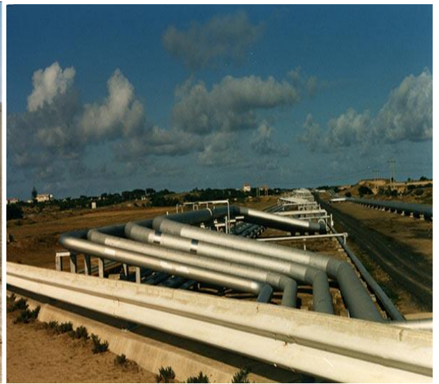
16 Сурет – Дөңгелек қисықты мұнай тасымалдайтын құбырлар
